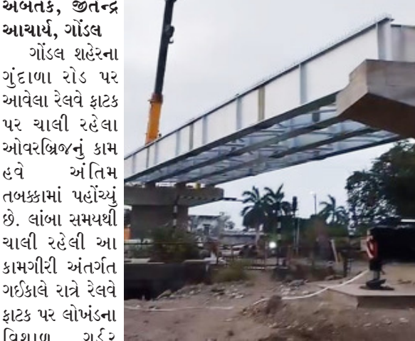
ગોંડલ શહેરના ગુંદાળા રોડ પર આવેલા રેલવે ફાટક પર ચાલી રહેલા ઓવરબ્રિજનું કામ હવે અંતિમ તબક્કામાં પહોંચ્યું છે. લાંબા સમયથી ચાલી રહેલી આ કામગીરી અંતર્ગત ગઈકાલે રાત્રે રેલવે ફાટક પર લોખંડના વિશાળ ગર્ડર (પોલ) ચડાવવાની મહત્વની કામગીરી હાથ ધરવામાં આવી હતી.
